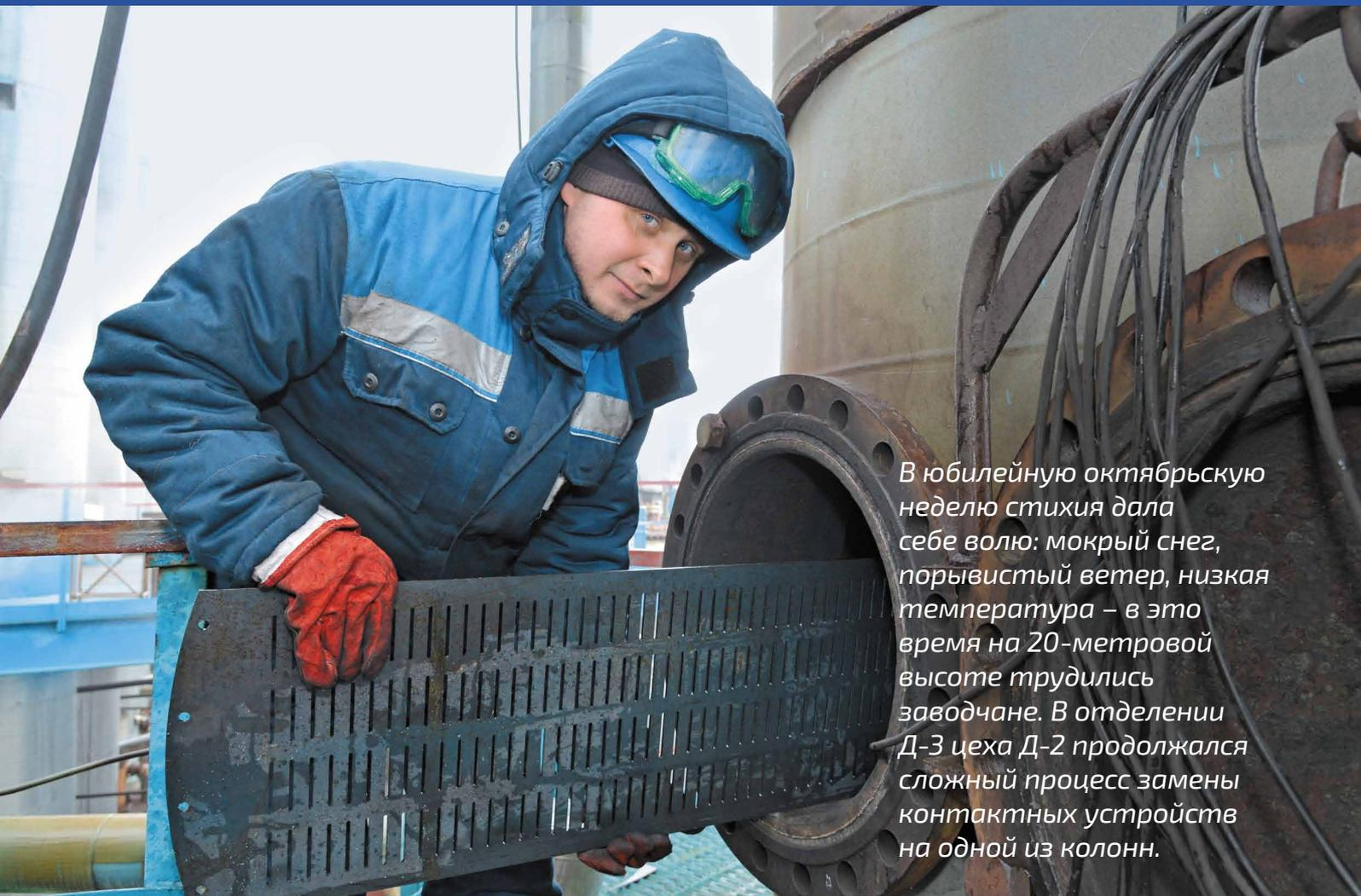
*В юбилейную октябрьскую неделю стихия дала себе волю: мокрый снег, порывистый ветер, низкая температура – в это время на 20-метровой высоте трудились заводчане. В отделении Д-3 цеха Д-2 продолжался сложный процесс замены контактных устройств на одной из колонн.*
