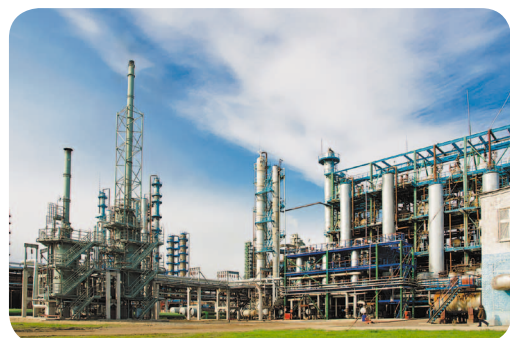
Промышленная площадка завода «Омский каучук»
