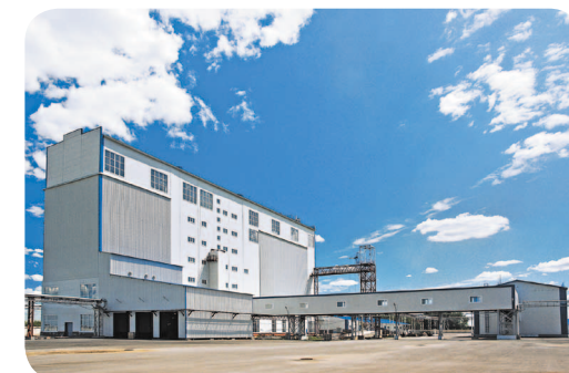
Комбикормовый завод Пушкинский
