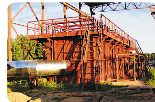
Уникальное инженерное решение – установка по выпуску органического углерода
